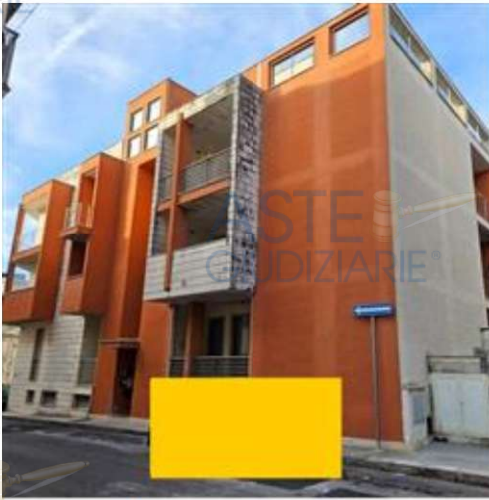
Prospetto fabbricato condominiale su via marconi
