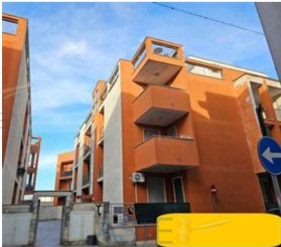
Prospetto fabbricato condominiale su via marconi
