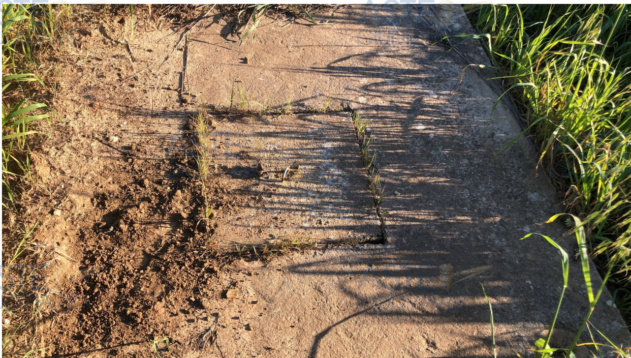
Immagine 06: Pozzo all'intero della particella 328
