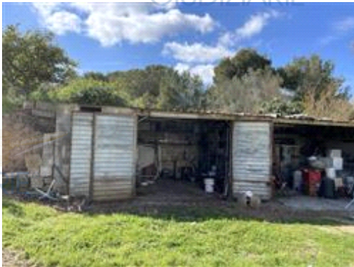
Vista della tettoia chiusa
