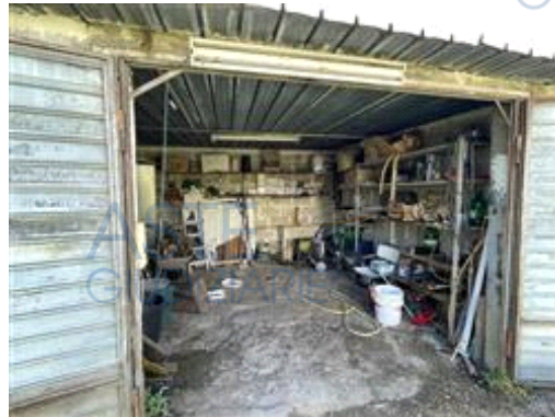
Vista della tettoia chiusa
