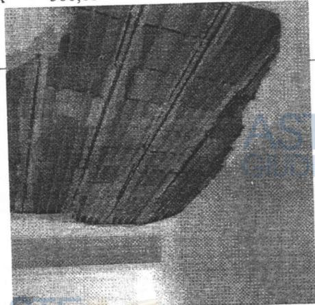
Sfondellamento solaio di copertura
