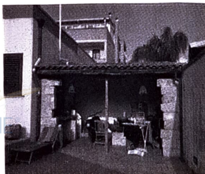
Tettoia da demolire sul lato sud del lotto
