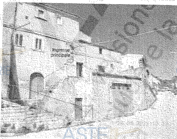
vista principale con indicazione ingresso soggiorno.
