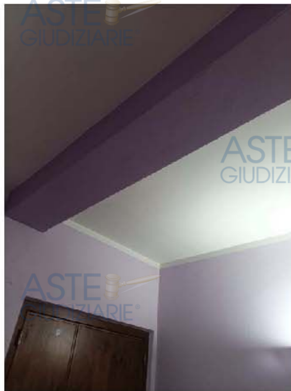
PARTICOLARE STRUTTURALE ALL'INGRESSO
