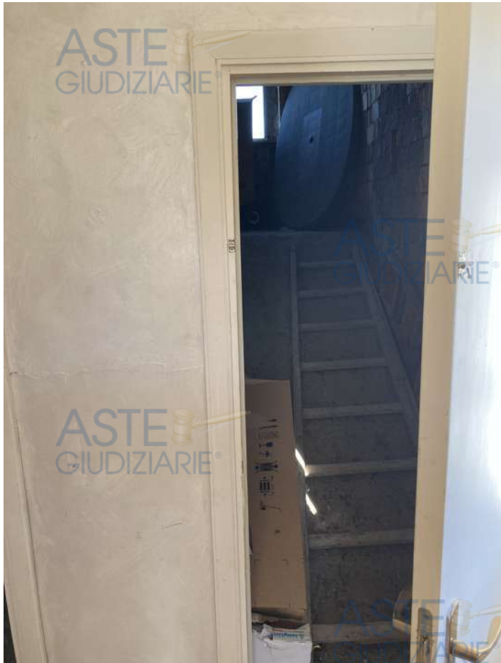
vista da ingresso verso sottotetto non praticabile
