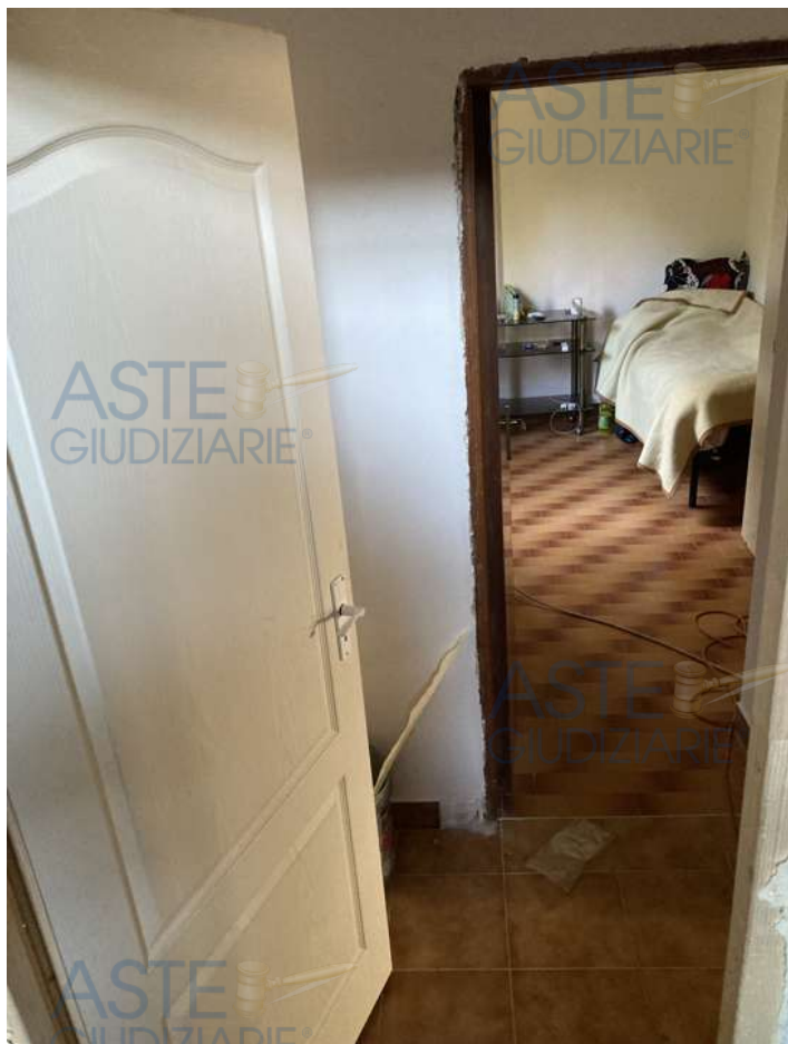
vista da vano scala (Sub 10) verso disimpegno e ripostiglio
