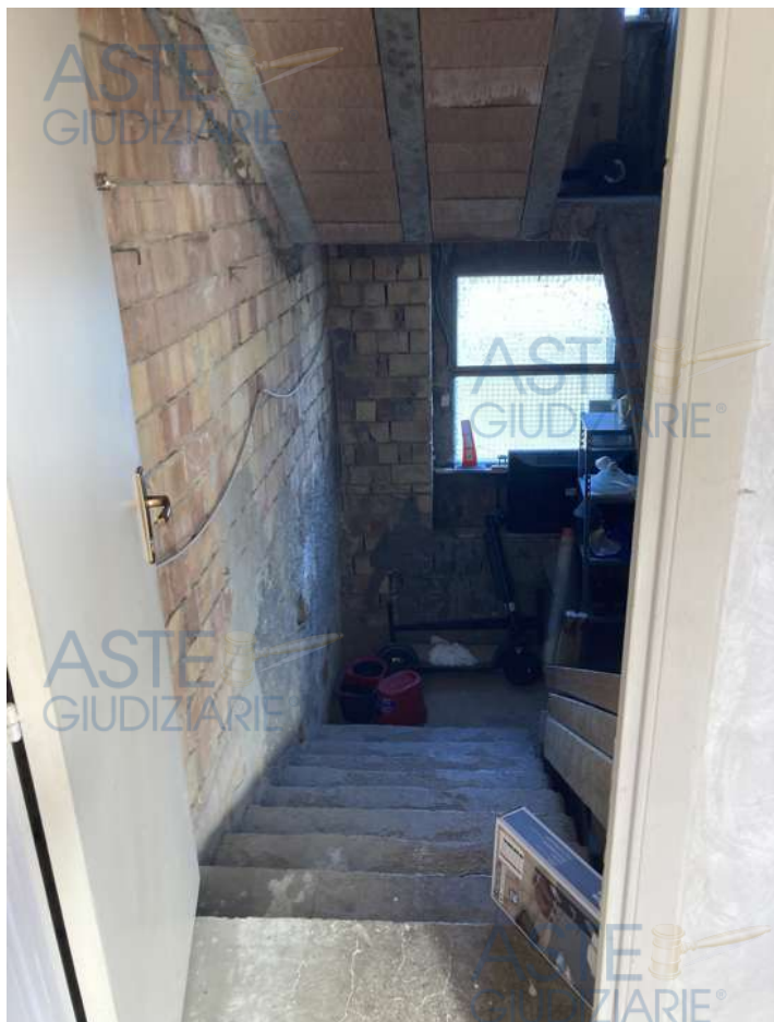
vista da ingresso verso vano scala a grezzo (Sub 10) che conduce al P.S1 (Sub 9)
