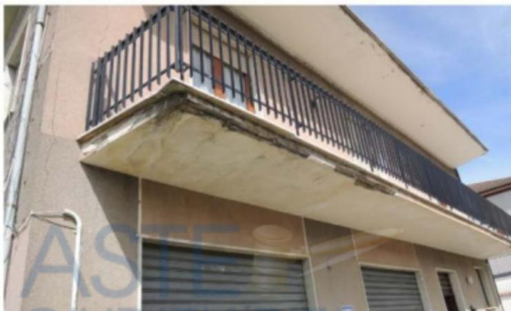
Figura 4 Particolare degrado sottobalcone e frontalino
