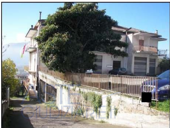
Percorso laterale di accesso all'u.i.
