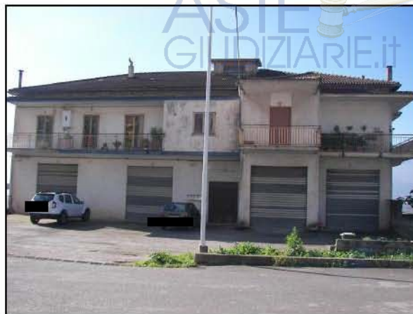
Fronte principale ed ingresso al fabbricato
