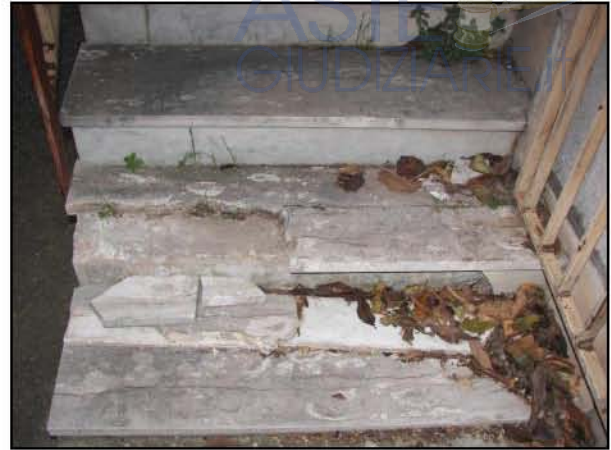
Scala esterna di accesso
