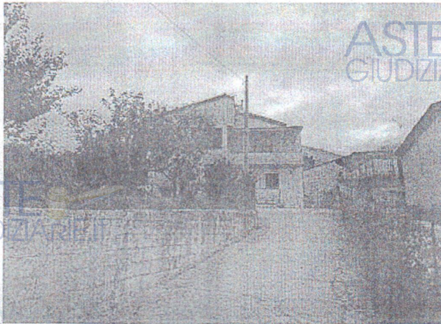
foto n° 1 - accesso al bene , dalla strada pubblica, attraverso la corte comune
