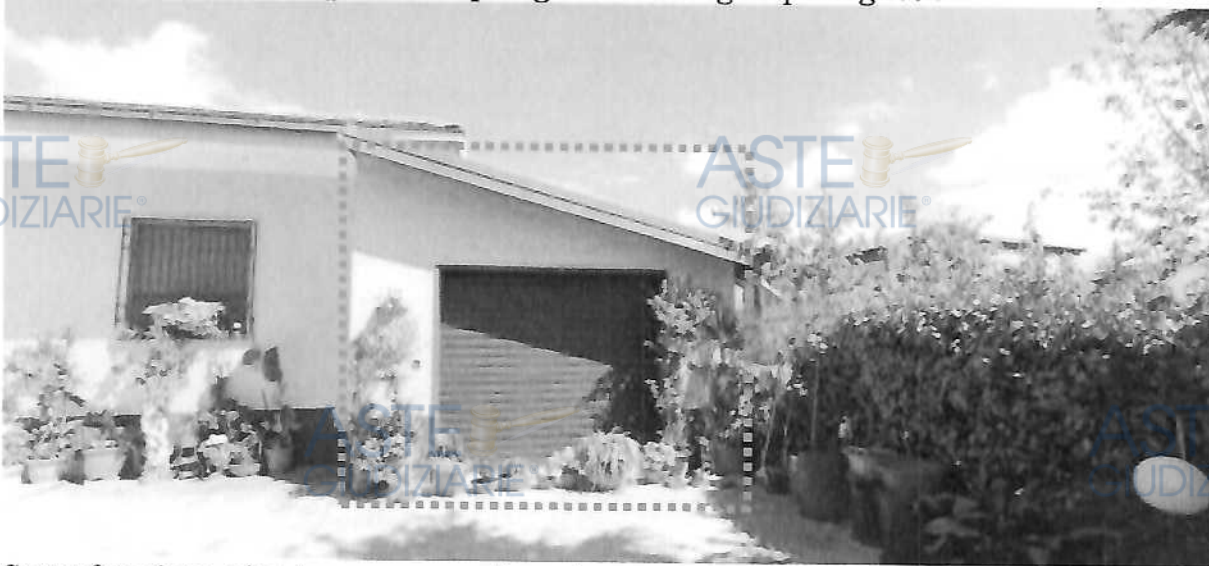
Superfetazione abusiva su prospetto est
