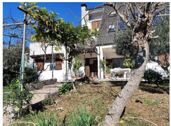
Foto 2 Vista esterna lato sud
