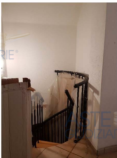
Foto 36 Accesso Sottotetto P2
