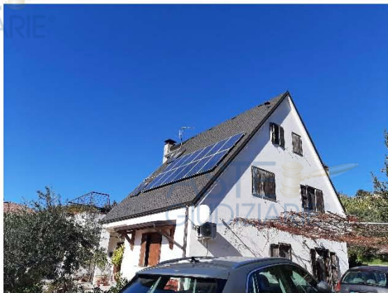
Foto 3 Vista esterna lato est
