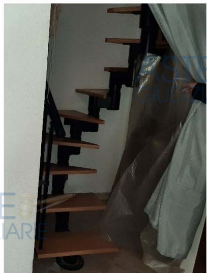
Foto 35 Accesso al Sottotetto dal P1
