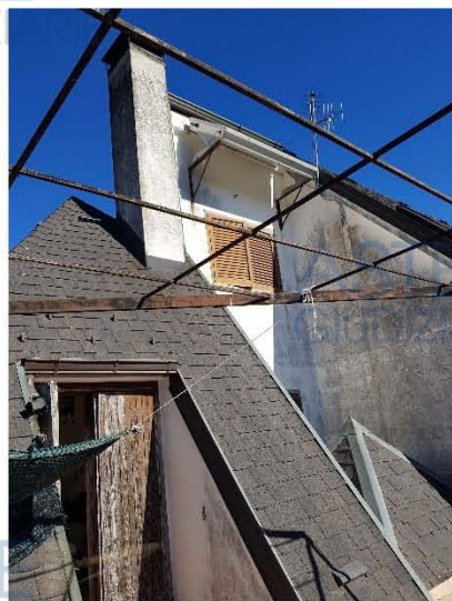
Foto 32 Particolare Tetti vista da terrazzo P1
