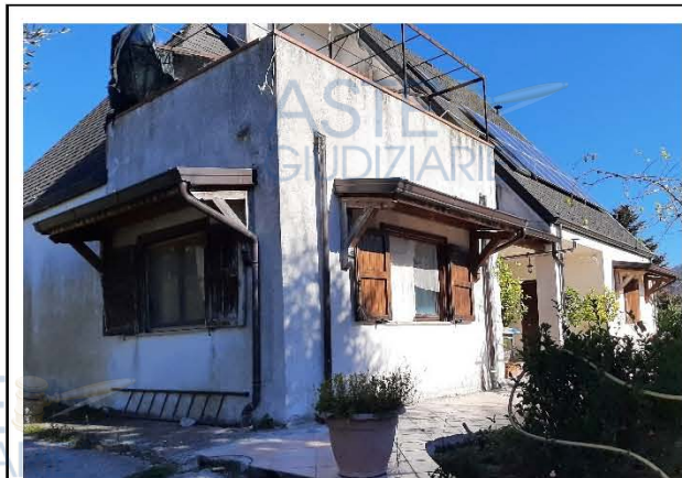
Foto 5 Particolare pensiline di protezione aperture
