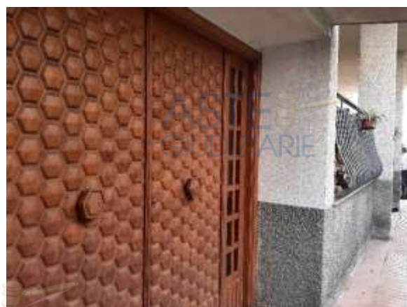
Foto 18 Particolare ingresso Vano scala (sub 2 Bcnc)
