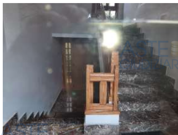
Foto 19 Particolare Vano scala (sub 2 Bcnc)
