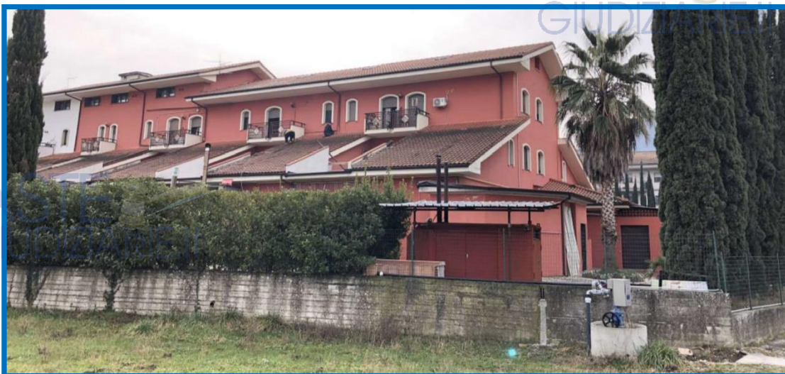
(foto Struttura prospetto posteriore)
