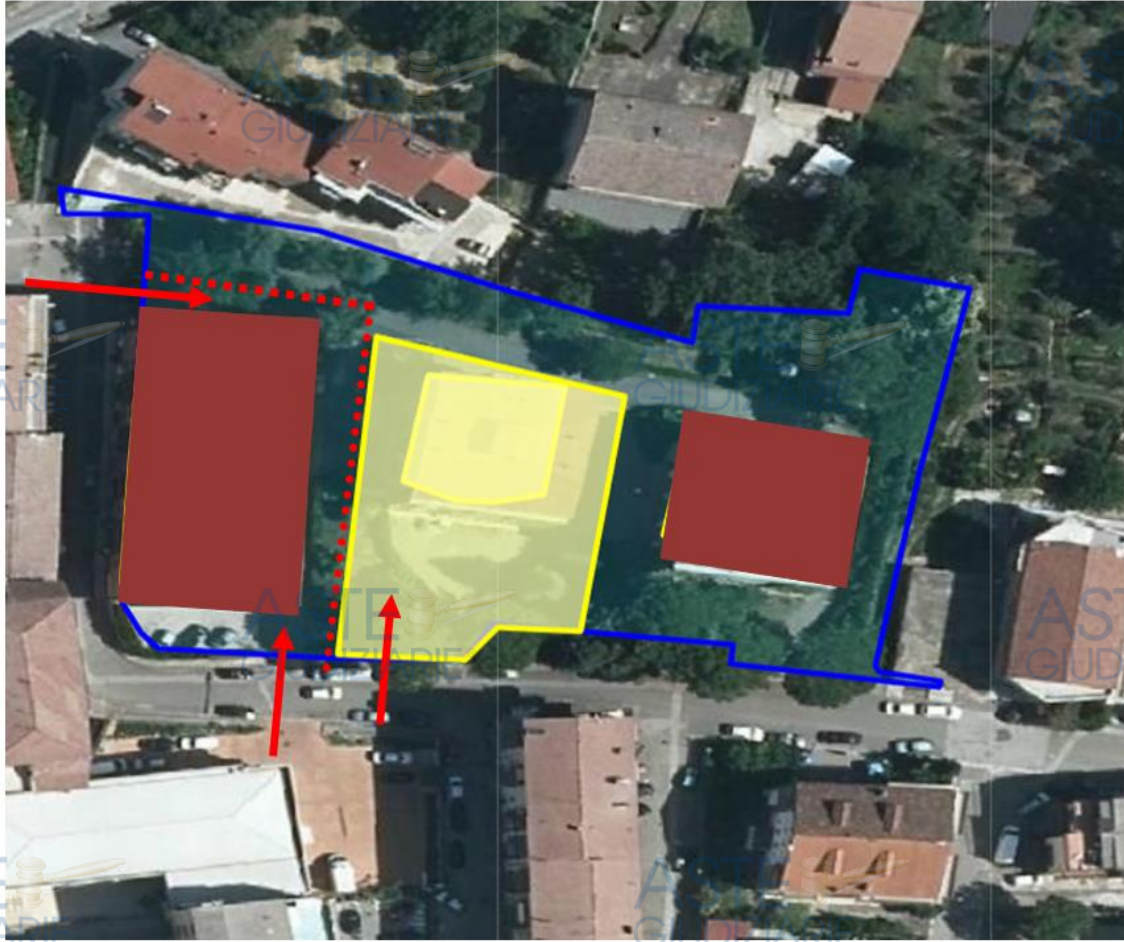
Figura 9 _Areee pertinenziali ed accessi ai fabbricati oggetto di pignoramento
