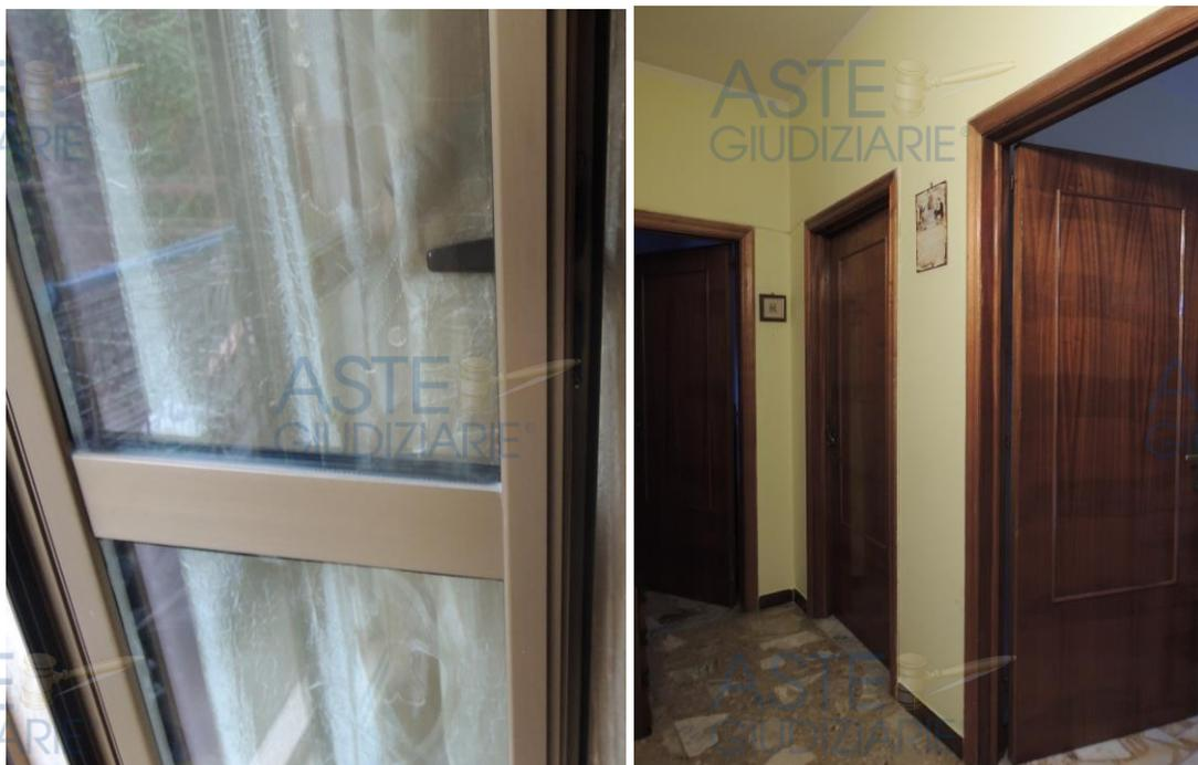
**Figura 7** Particolare infissi esteni in alluminio **Figura 8** Particolari infissi interni in legno tamburato
