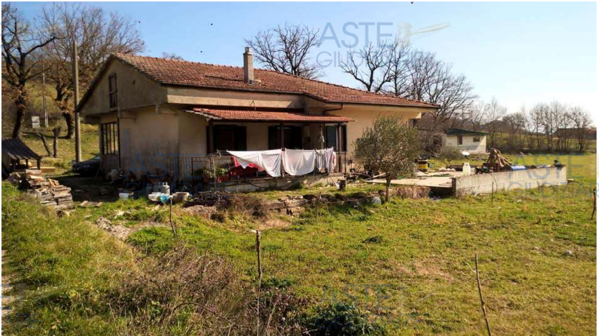
Foto n. 3 – prospetto nord ovest
