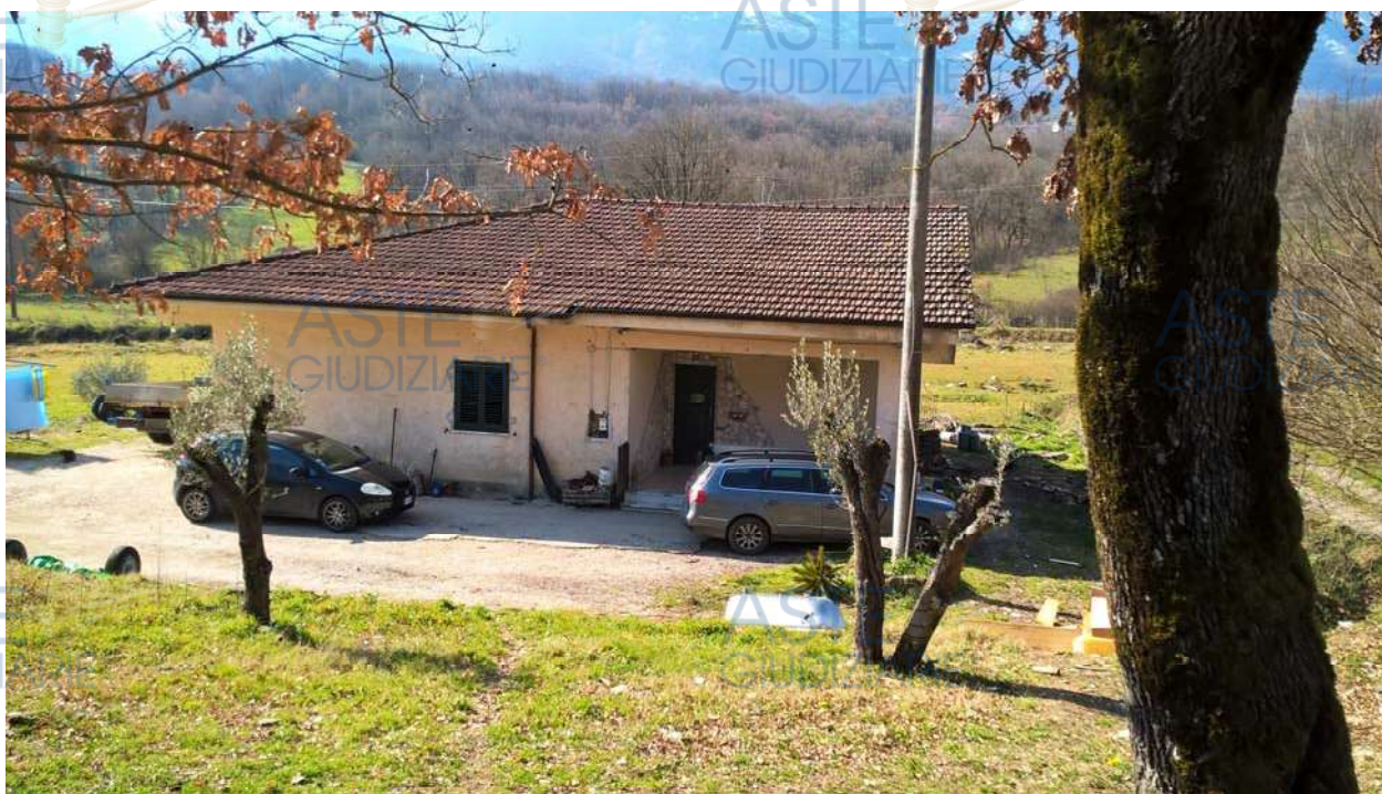
Foto n. 1 – prospetto su via Calaprece
