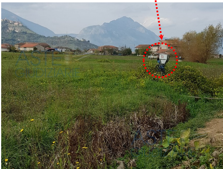
Foto 6 Particolare presa idrica del Consorzio di bonifica
