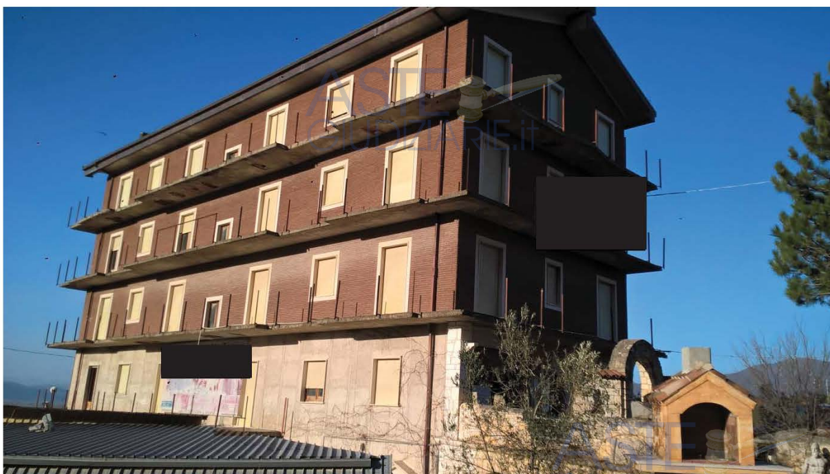
Foto n. 2 – prospetto sud ovest
