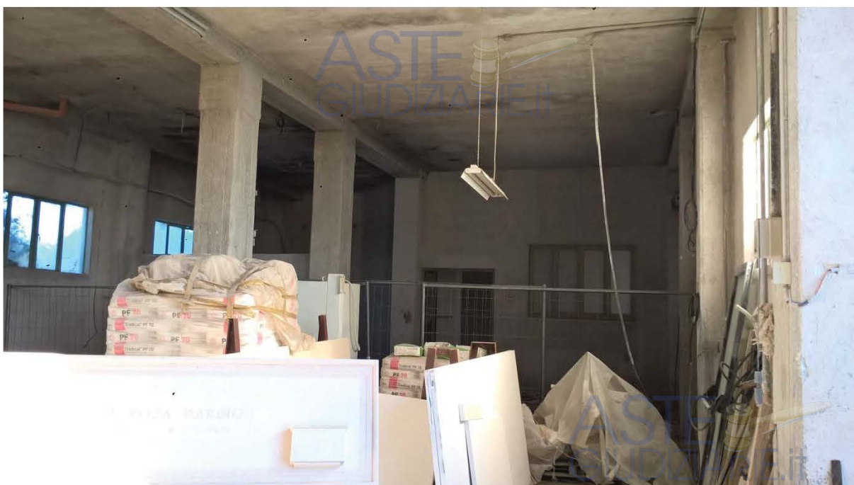
Foto n. 10 – interno locale piano seminterrato
