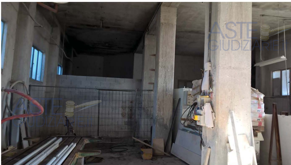
Foto n. 9 – interno locale piano seminterrato
