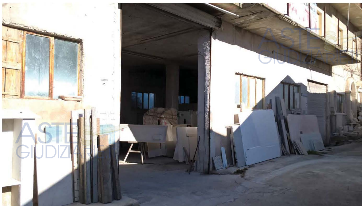
Foto n. 7 – ingresso al locale seminterrato
