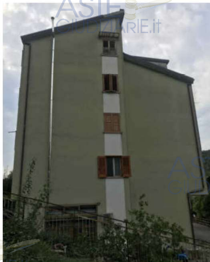
FOTO PROSPETTO NORD
