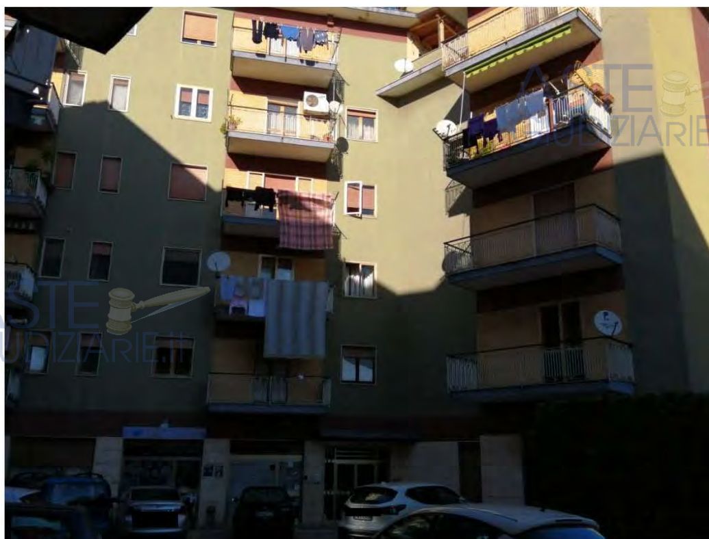
Foto n. 1 – prospetto sud del fabbricato lato ingresso
