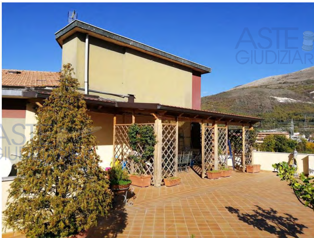
Foto n. 3 – terrazza e prospetto sud est dell'appartamento
