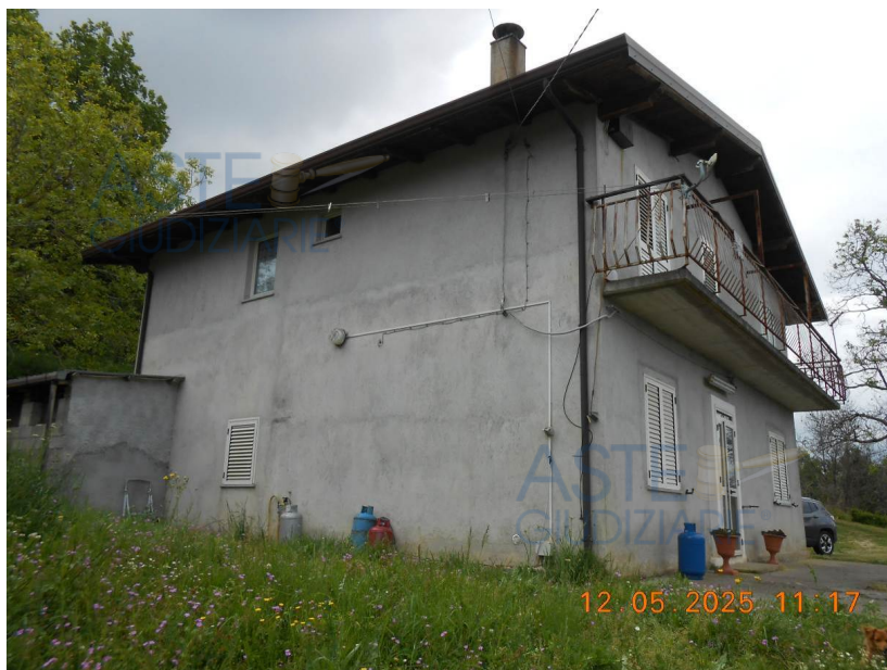
Foto lato nord-est dell'immobile "A": abitazione a 2 p.f.t.
