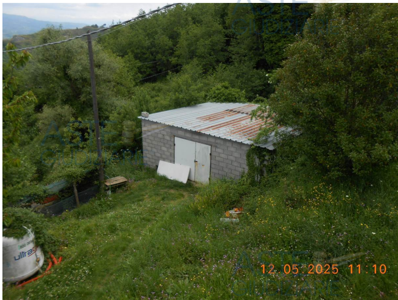
Foto lato sud-ovest dell'immobile "C": garage a 1 p.f.t.
