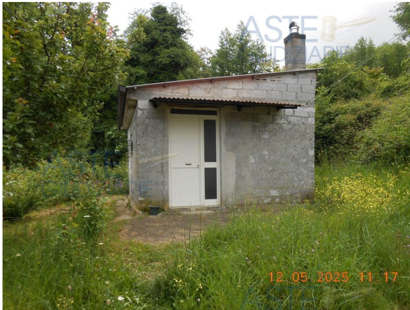
Foto lato ovest dell'immobile "B": deposito a 1 p.f.t.
