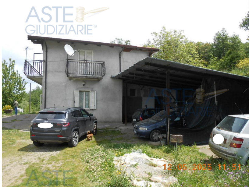
Foto lato sud-ovest dell'immobile "D": tettoia n. 3 a 1 p.f.t.
