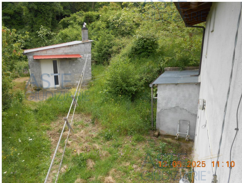
Foto lato nord-ovest dell'immobile "E": corte di esclusiva pertinenza
