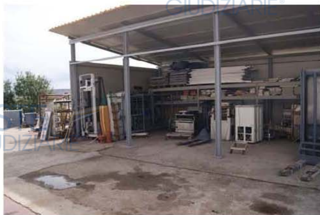
FOTO 2 _ Esterno: Tettoia (P.T.)
