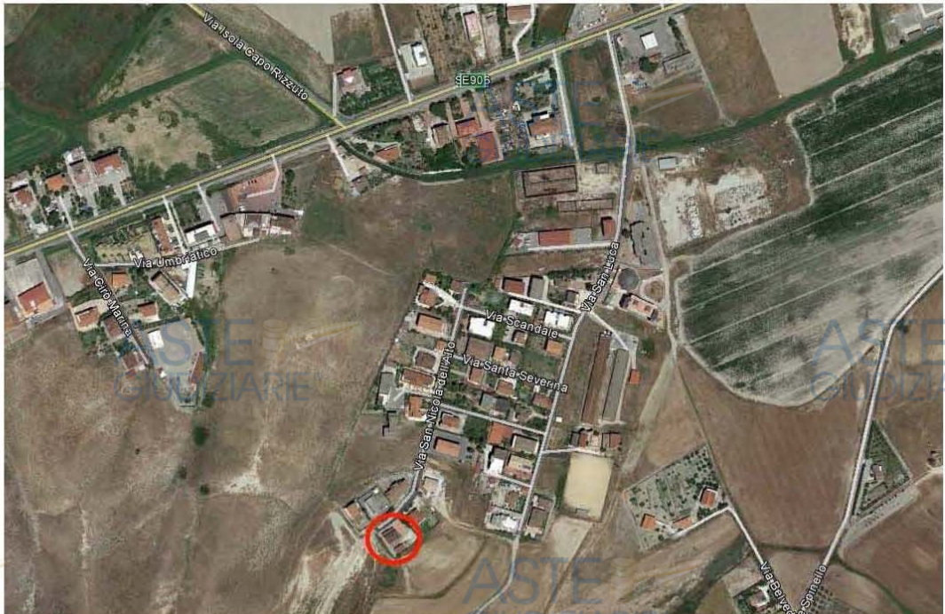
Ortofoto – Localizzazione dell'immobile
