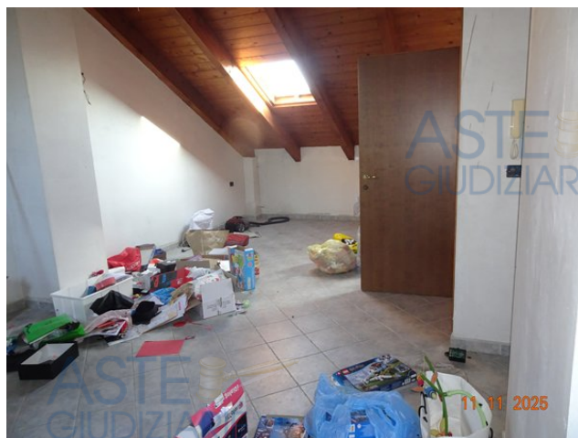
Sottotetto non abitabile
