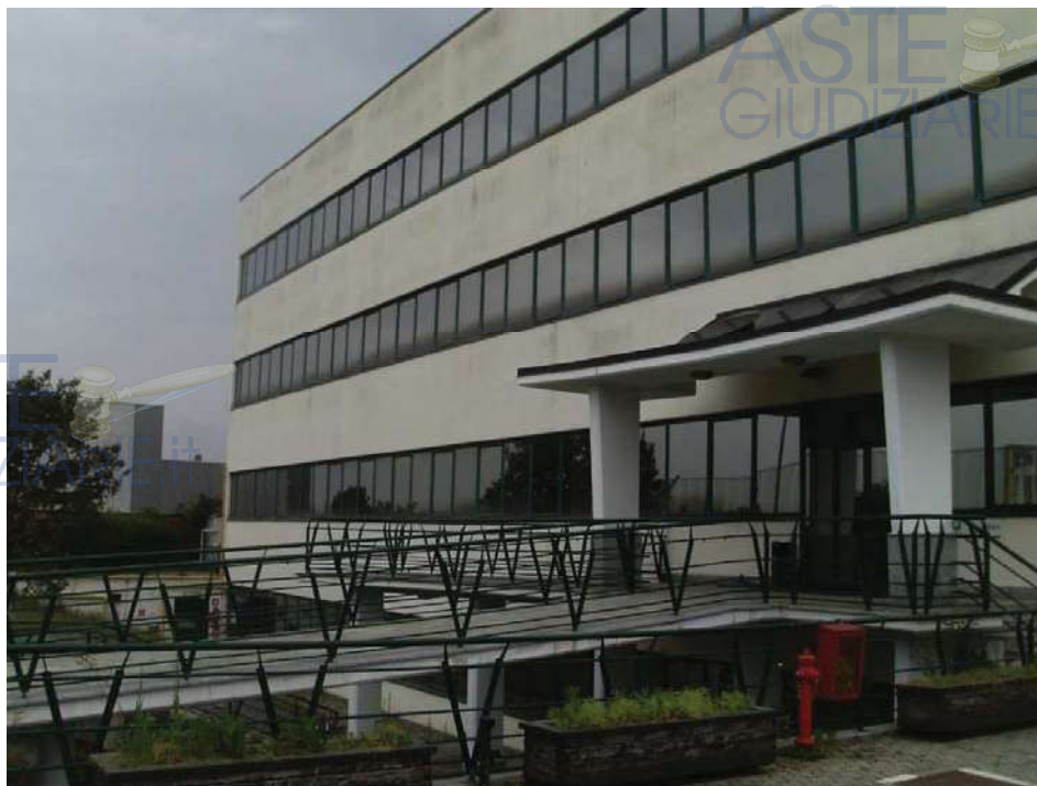
Figura 2 lato E ingresso
