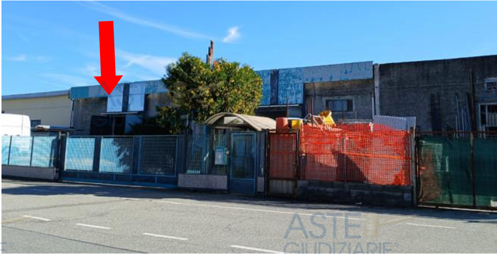
Vista (dalla via Carpi) dell'unità immobiliare pignorata e dell'area esterna in parola.
