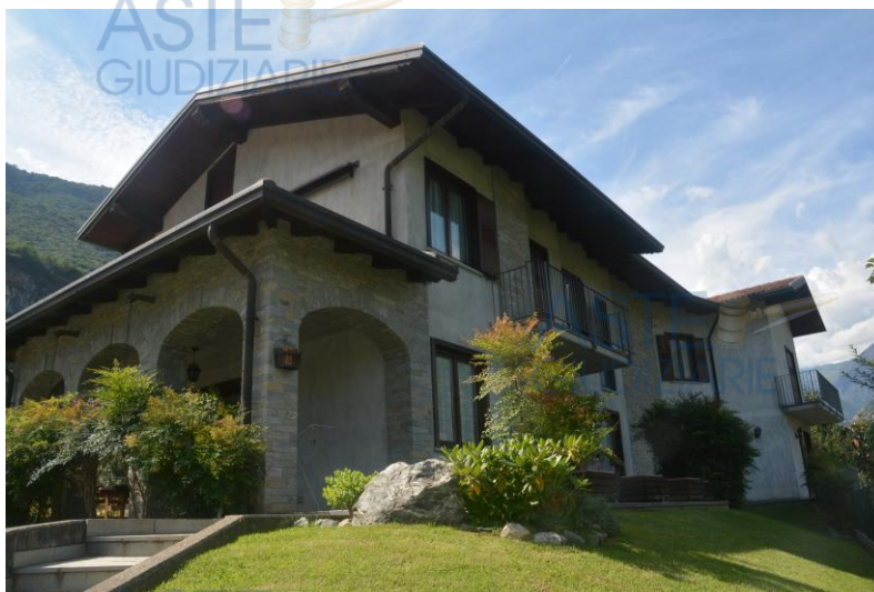
Foto – Vista fabbricato lato sud / est
