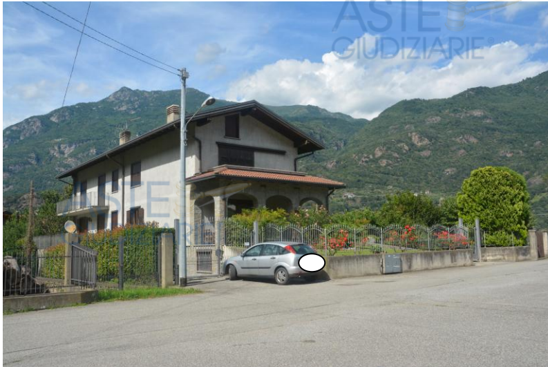
Foto – Vista fabbricato lato sud / ovest
