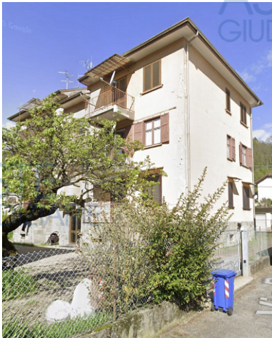
FOTO 1 - ESTERNO DEL CONDOMINIO
