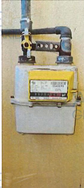
La tubazione è realizzata in acciaio, ma non è stato possibile accertare le caratteristiche delle tubazioni sottotraccia, probabilmente anche quest'ultime in metallo, e della rete interna, per cui non è possibile esprimere parere in merito alla rispondenza alle vigenti UNI 7129.
