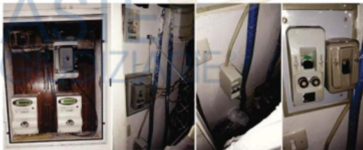
Nell'appartamento la distribuzione dell'impianto elettrico è stata eseguita con posa delle linee sottotraccia e in parte in esterna; i dispositivi di comando (interruttori, deviatori, invertitori, ecc...) e le prese sono realizzati prevalentemente con posa ad incasso nella parete; i dispositivi risultano essere di remota installazione, i frutti ove sono alloggiate le prese, gli interruttori e i deviatori risultano essere dotati di mascherine.
