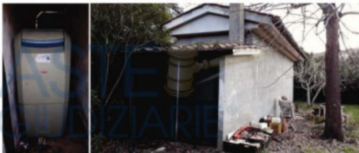
La produzione di ACS avviene inoltre tramite un boiler elettrico installato in prossimità della caldaia.
