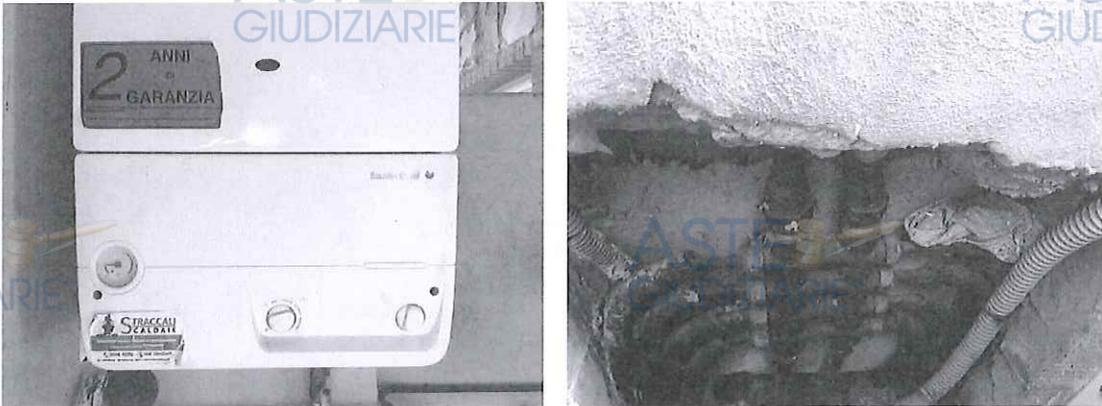
Figura 3: Caldaia e collettore complanare riscaldamento
