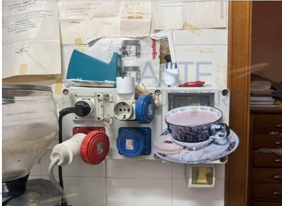
Prese 220 e 380V protette da int. magnetotermico trifase
