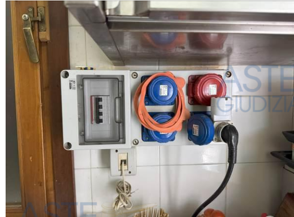
Prese 220V e 380V protette da int. magnetotermico trifase
