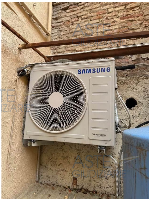
Unità esterna sub. 14 potenza in raffrescamento 6,8 kW potenza in riscaldamento 8 kW
