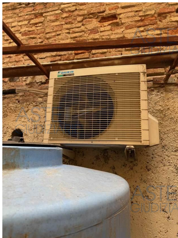
Unità esterna sub. 15 potenza in raffrescamento 3,7 kW potenza in riscaldamento 4,4 kW
