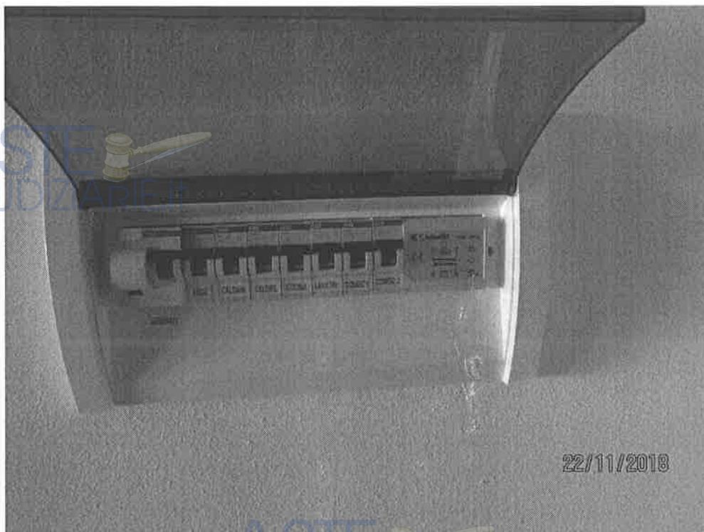
Trattasi di quadro elettrico da incasso, 12 moduli, classe 2, nel quale si riscontra interruttore magnetotermico differenziale generale oltre n. 7 interruttori magnetotermici a servizio delle utenze contrassegnate con targhetta identificatrice.
