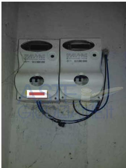
A tale dispositivo sono collegati conduttori che raggiungono il quadro elettrico di distribuzione, posizionato all'interno dell'appartamento, costituito da un centralino in plastica incassato nella muratura da 12 moduli, privo di sportello di chiusura, al cui interno sono presenti:
