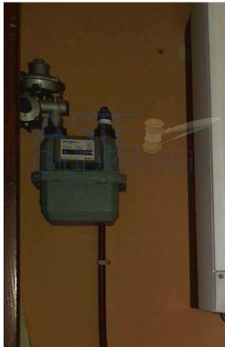
All'interno dell'appartamento, nel punto in cui la tubazione del gas fuoriesce dalla muratura, è visibile la guaina impermeabile al gas dentro la quale è contenuto il tubo metallico.
