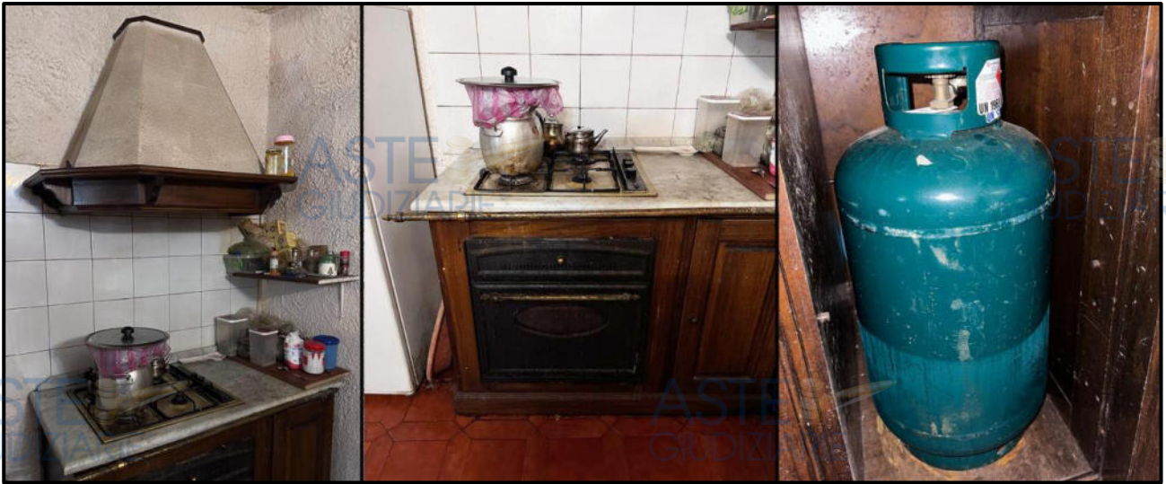
Impianto gas: alloggiamento bombola GPL in cucina
