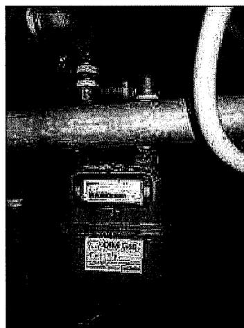
Dai contatori, tramite tubazioni in parte a vista e in parte interrata, il combustibile viene distribuito agli utilizzatori (caldaie e piano cottura); in prossimità degli stessi sono installati dispositivi manuali di intercettazione (rubinetto).
