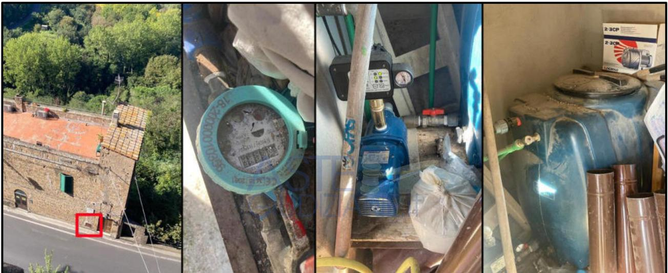
**Impianto idrico: punto di fornitura e alloggiamento contatore, autoclave ed accumulo nel vano tecnico**
