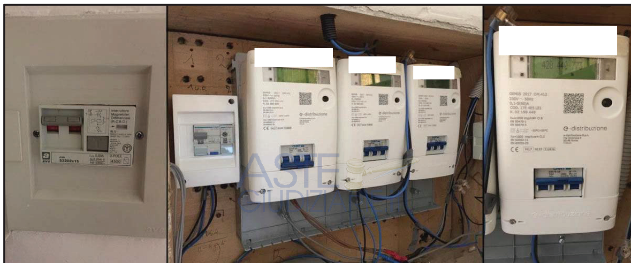
Impianto elettrico: punto di fornitura con contatore e quadretto posto all'interno dell'immobile
