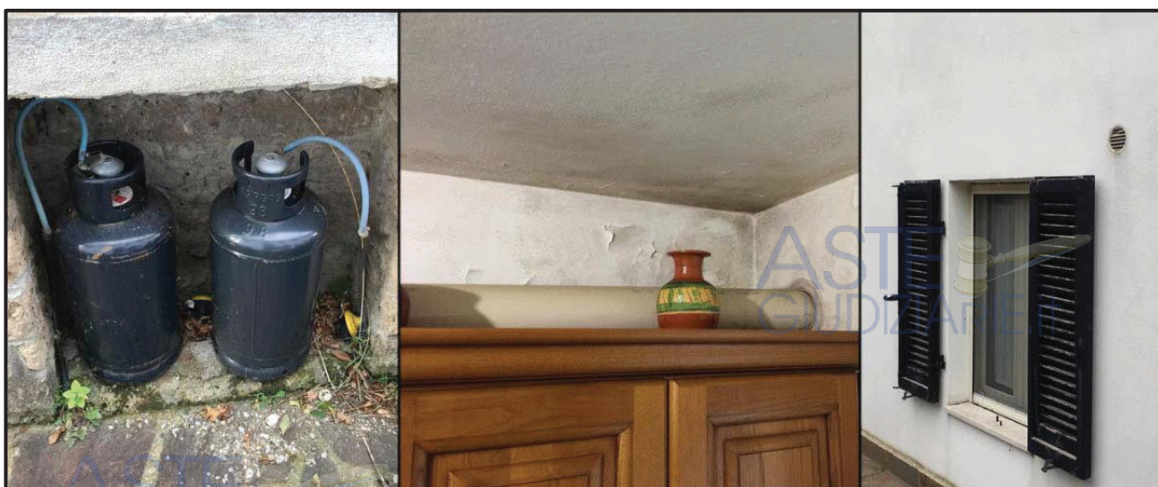
Impianto gas: bombole gpl e cappa aspirante terminante in facciata
