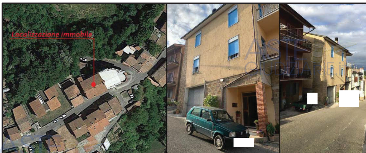
Lotto A: Accesso all'immobile: ortofoto e vista complessiva del fabbricato
