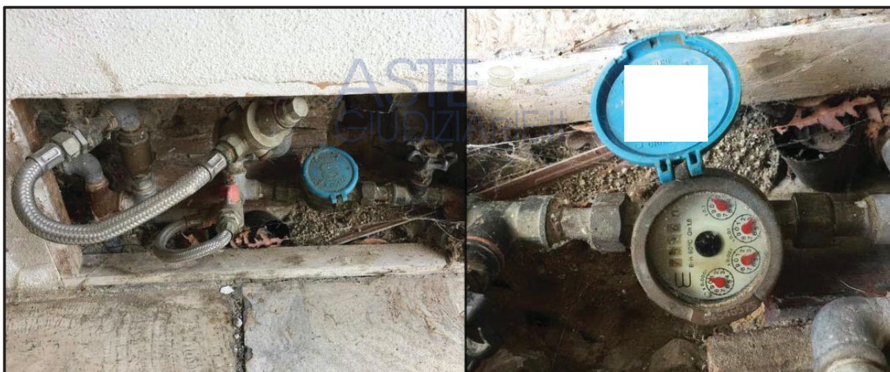
Contatore per fornitura acqua
