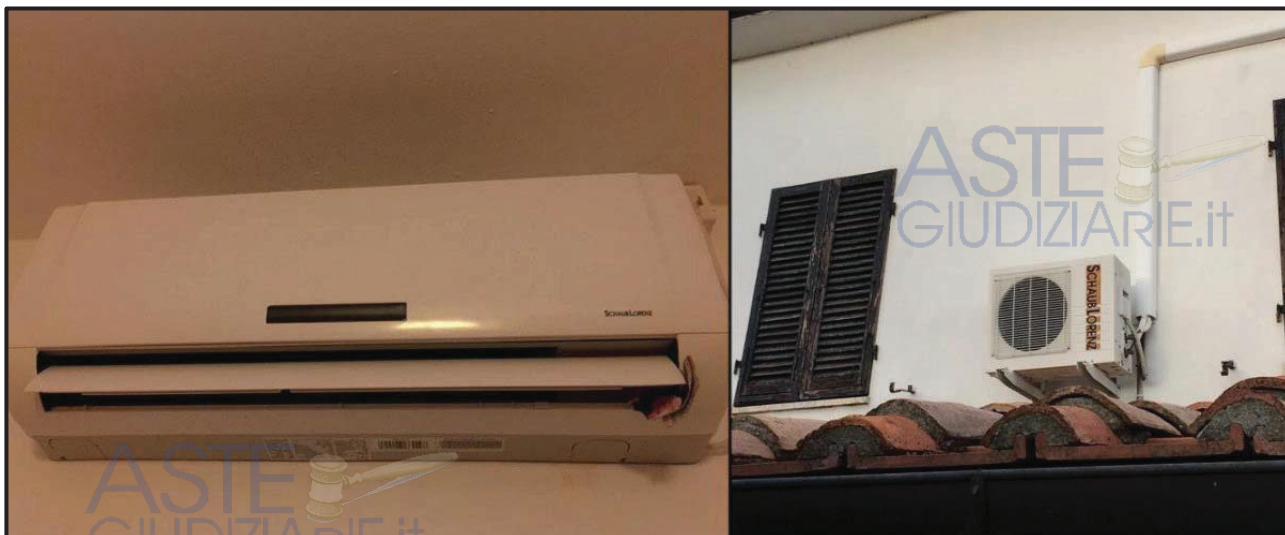
Pompa di calore mono con split.
