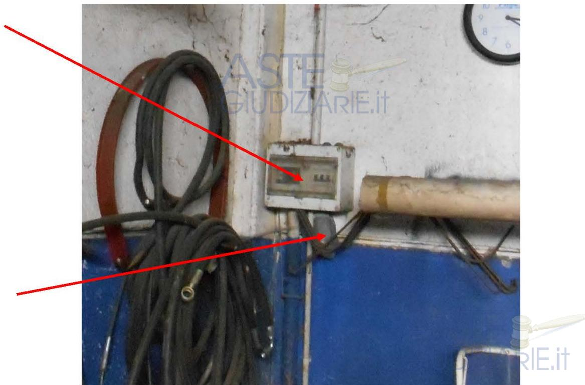
Foto N. 8 (Presa 2p+T senza interruttore di blocco e quadretto di protezione a monte)
