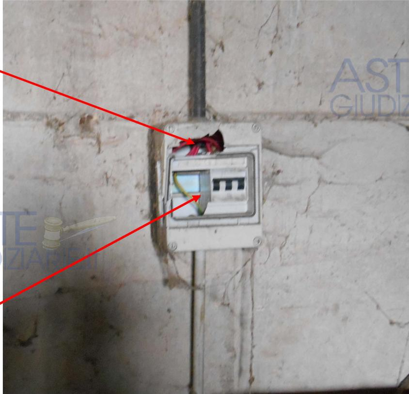
Foto N. 12 (Centralino rotto in più punti, possibile contatto con parti attive)
