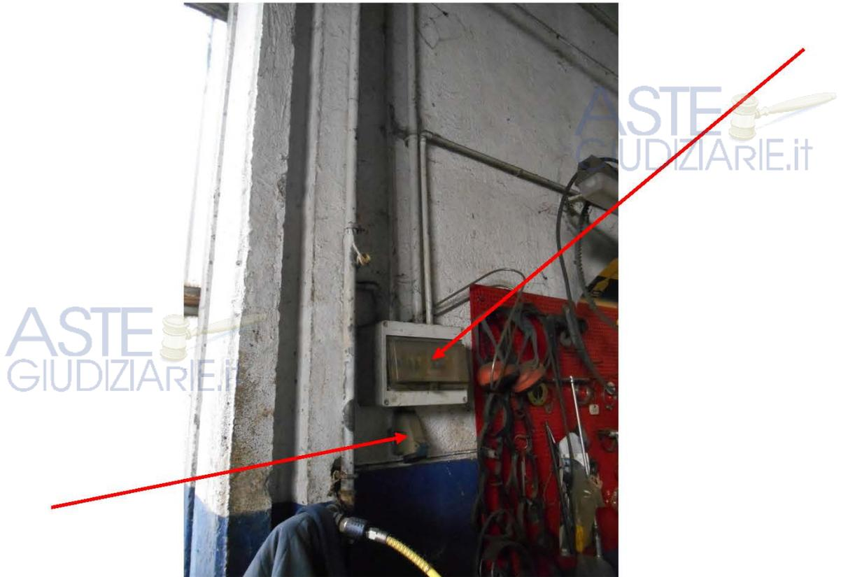
Foto N. 7 (Presa 2p+T senza interruttore di blocco e quadretto di protezione a monte)
