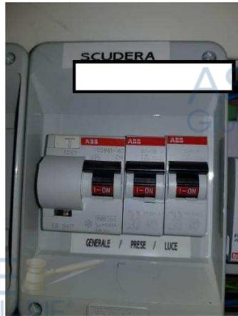
Il quadro elettrico di distribuzione dell'appartamento è realizzato con centralino in resina dotato di sportello e fissato su contenitore incassato nella muratura, ed è posizionato all'ingresso dell'appartamento.
