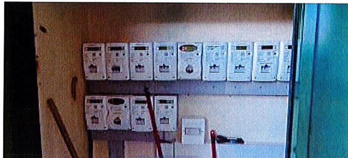
A tale dispositivo sono collegati conduttori che raggiungono, tramite canaline in PVC, un quadro elettrico, anch'esso posizionato all'interno della nicchia, che protegge la linea di alimentazione dell'abitazione, realizzato con un centralino in resina a parete, senza sportello di chiusura, al cui interno è installato:
