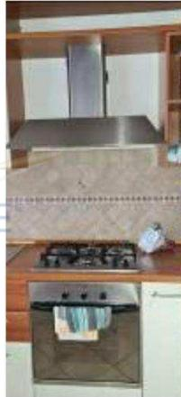
Non sono presenti le prescritte aperture di aerazione e di ventilazione di cui alla UNI 7129. Il locale è comunque aerabile mediante la finestra perimetrale ed indirettamente dagli infissi adiacente.
