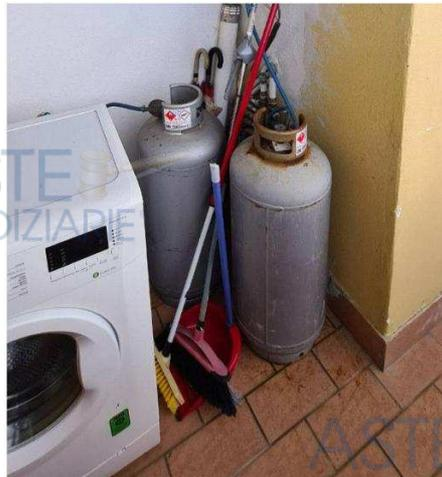
La tubazione è realizzata in tubo per impianti a Gas tipo Boagas, ma non è stato possibile accertare le caratteristiche delle tubazioni sottotraccia, probabilmente anche quest'ultime in rame, e della rete interna, per cui non è possibile esprimere parere in merito alla rispondenza alle vigenti UNI 7129.
