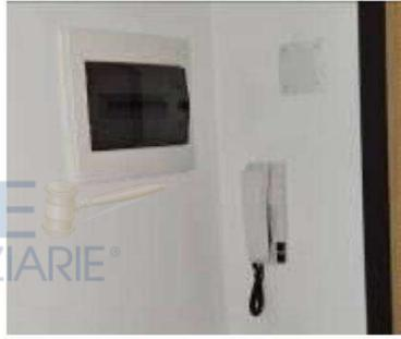
Nel quadro elettrico sono presenti le indicazioni per l'identificazione delle linee alimentate dai vari dispositivi ma non è presente la targa identificativa del quadro, come invece previsto dalla Norma CEI 23-51.
