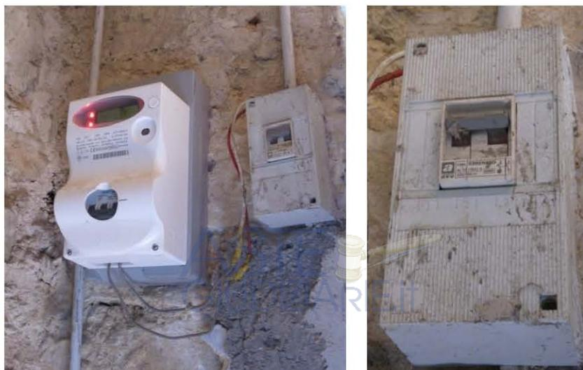
Fig. 22 e 23 – Collocazione contatore Enel e particolare interruttore magnetotermico
