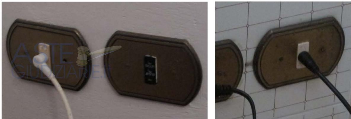
**Fig. 4 e 5** – Prese antenna tv terrestre
