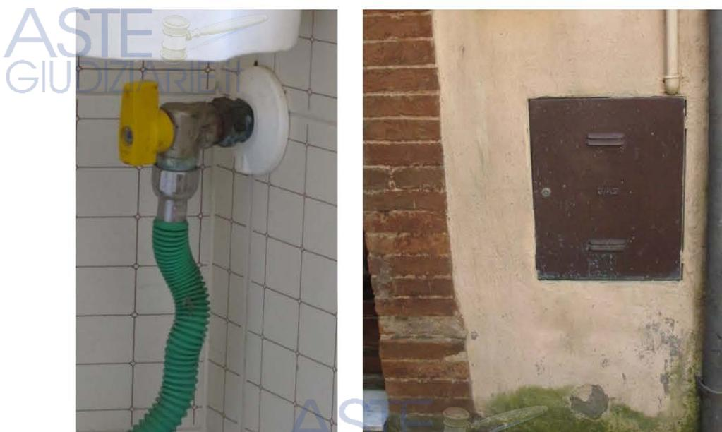
Fig. 20 e 21 – Rubinetto d'intercettazione gpl e collocazione contatore
