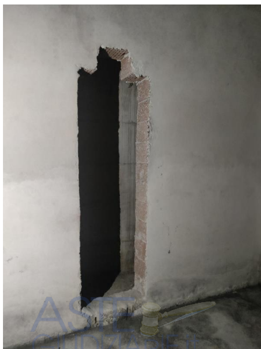
Foto 56: apertura C di accesso al locale interrato
