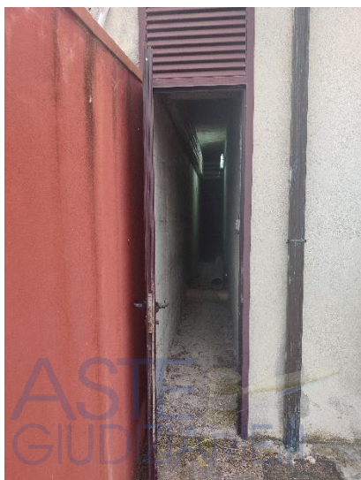
Foto 54: dall'ingresso si vede lo stretto scannafosso, ovviamente buio:
