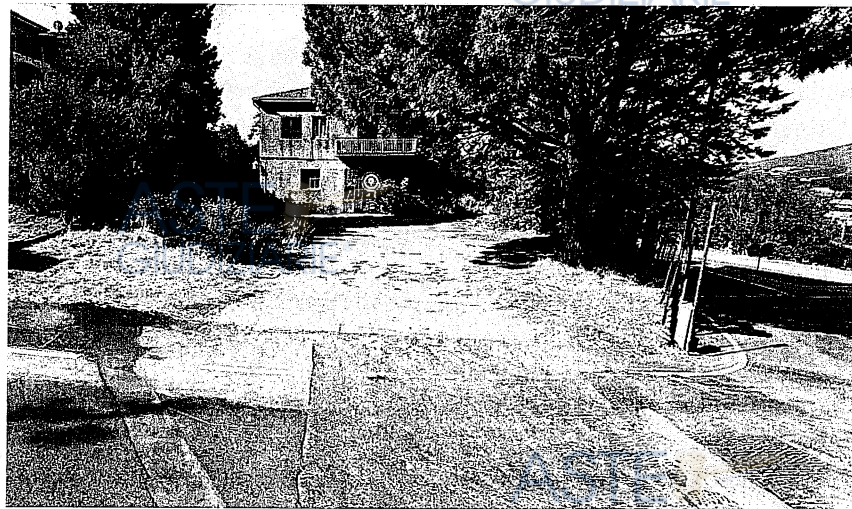
Figura 2 – Vista d'insieme del fabbricato dalla via Sant'Agata
