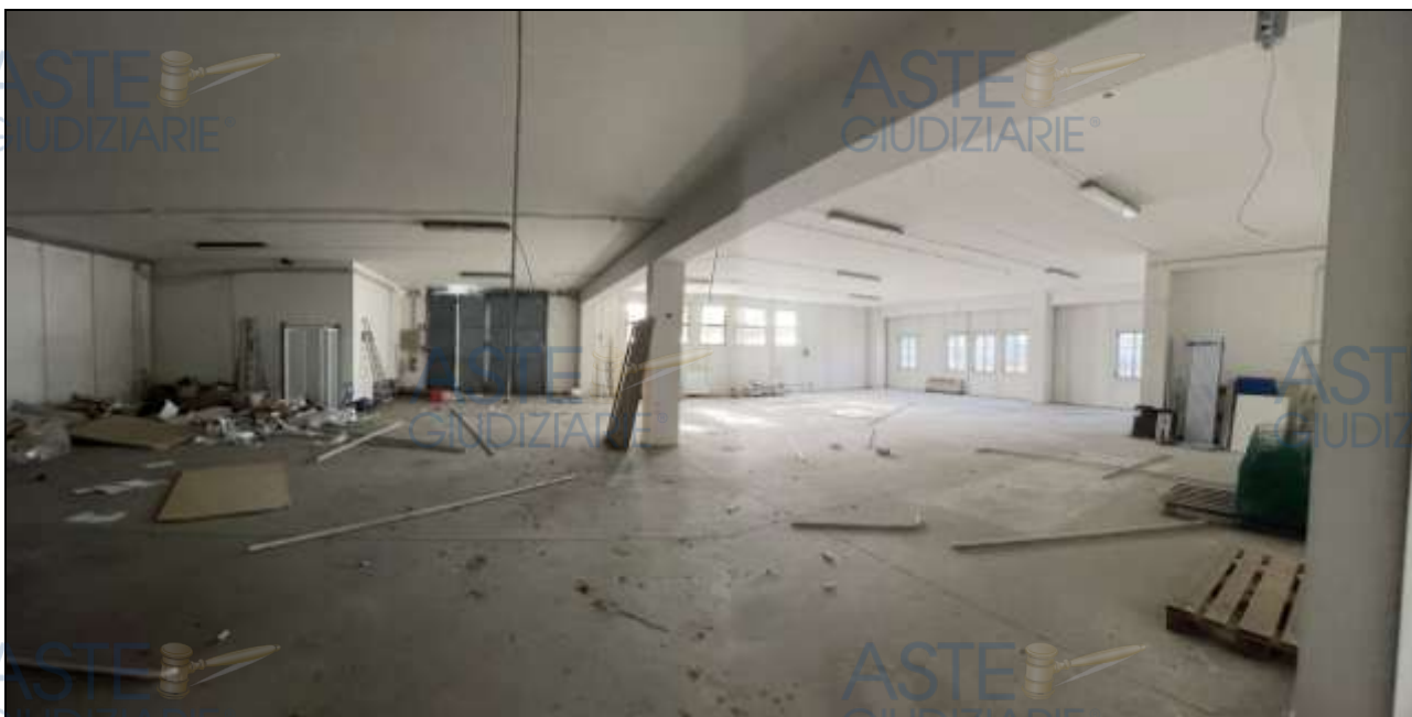
Foto "50" – PIANO TERRA – Magazzino – Zona sud-ovest
