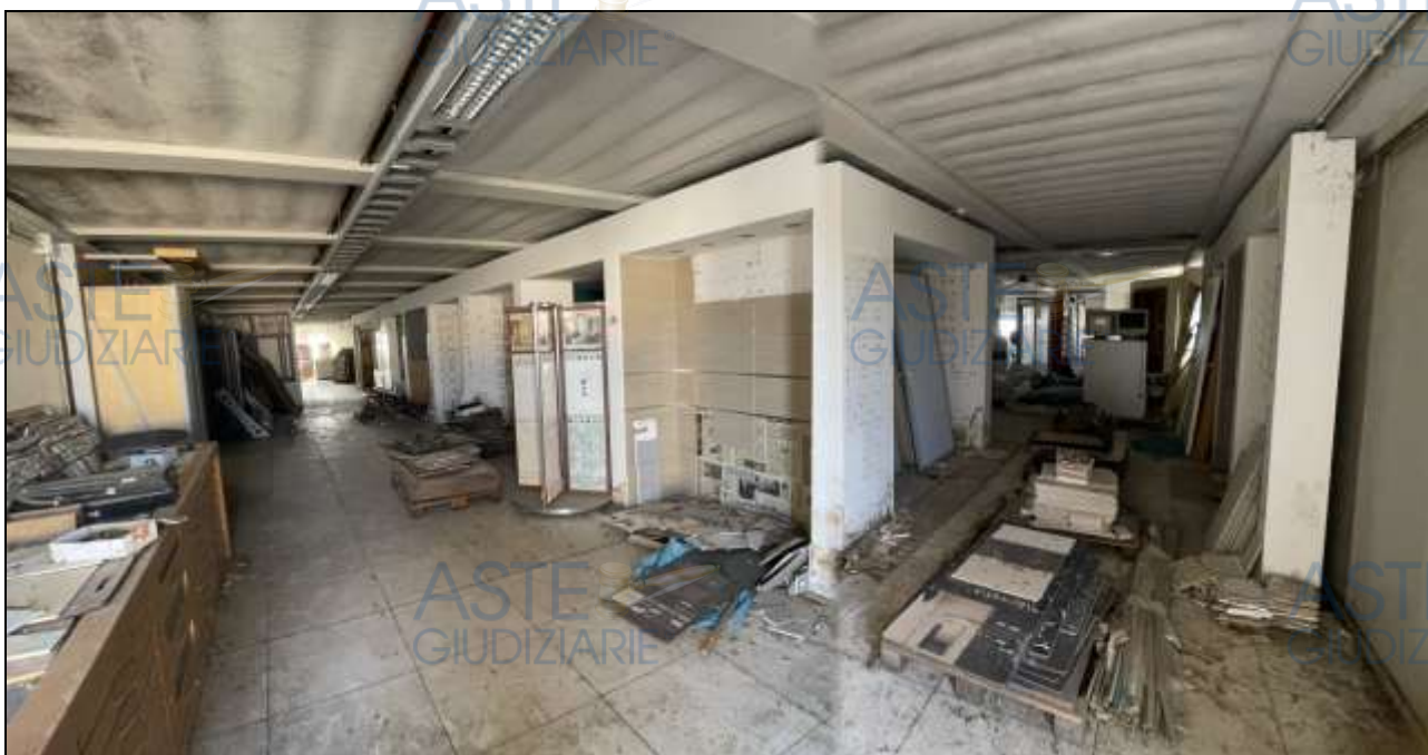
Foto "63" – PIANO PRIMO – Magazzino – Zona ovest
