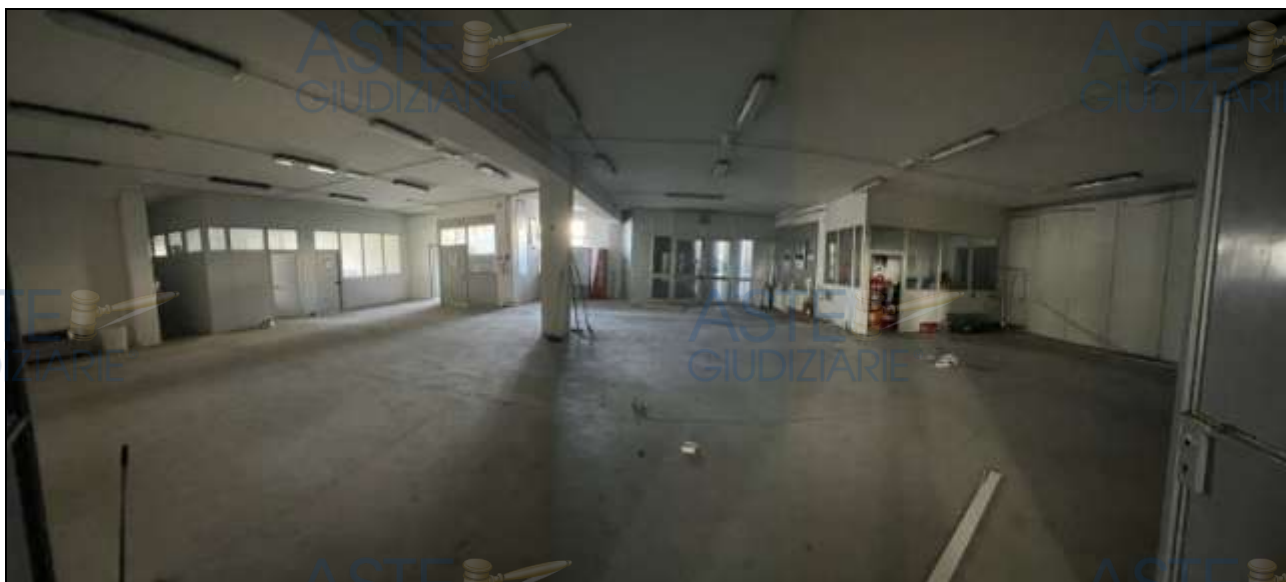
Foto "43" – PIANO TERRA – Magazzino – Zona nord-ovest
