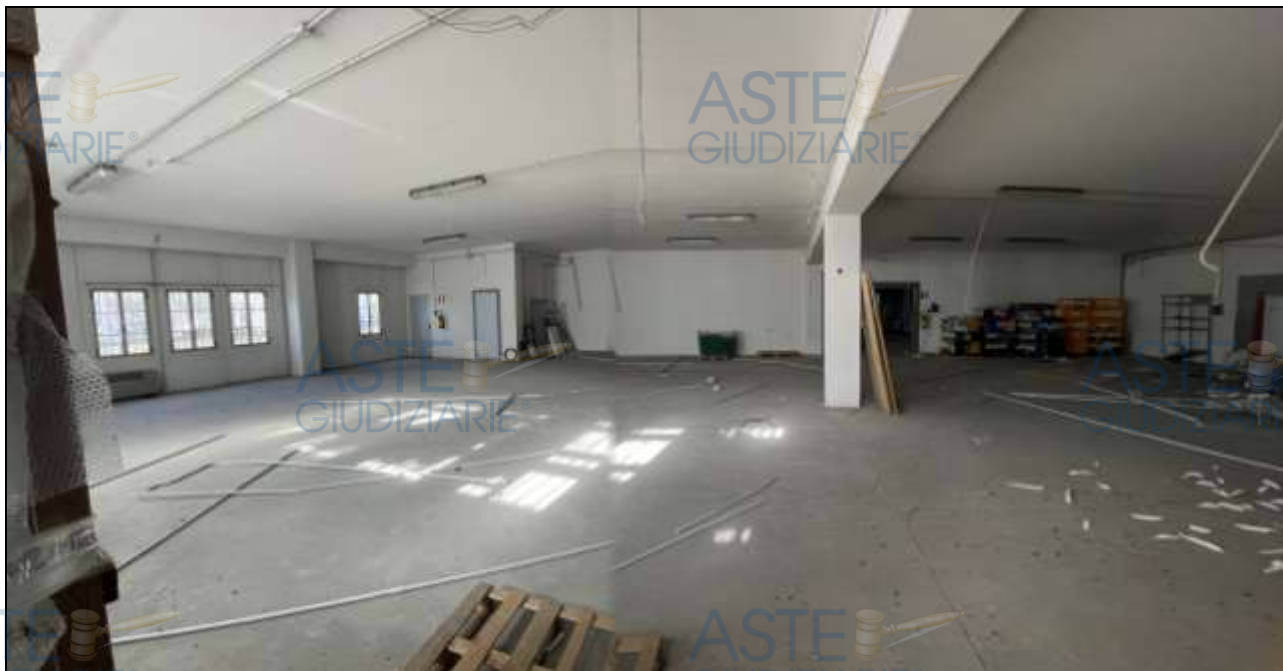
Foto "51" – PIANO TERRA – Magazzino – Zona sud-ovest
