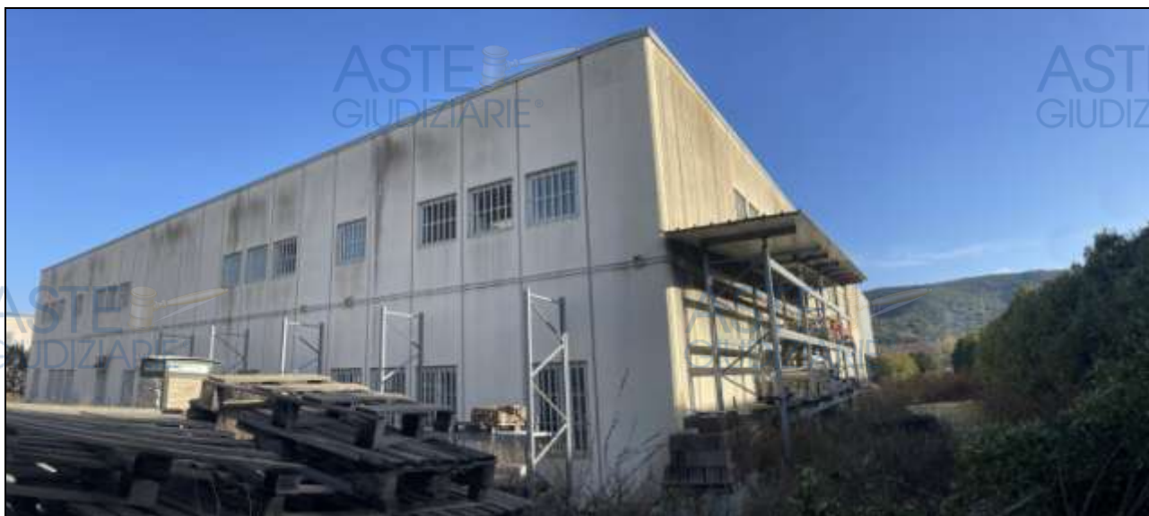
Foto "10" – Vista dalla corte esclusiva – zona ovest / sud-ovest
