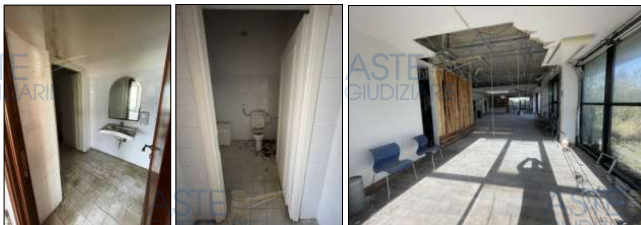
Foto "30-31-32" – PIANO TERRA – Serv. Igien. disabili ed Area Vendita-Somministrazione
