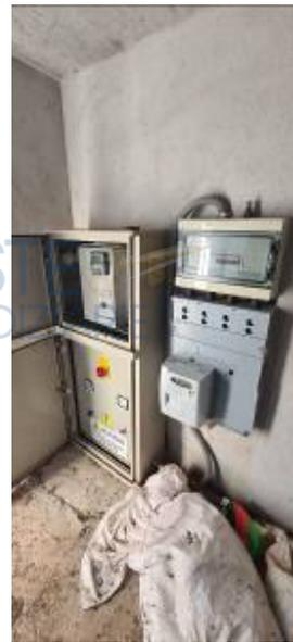
A tale dispositivo sono collegati conduttori a vista che alimentano un interruttore quadripolare differenziale, marca ABB, modello DDA204 AC con soglia di sensibilità di 0,3A accoppiato ad un interruttore quadripolare magnetotermico, marca ABB, modello S204 C63 da 25A con potere di interruzione di 6,0 kA, posti all'interno di un quadro elettrico a parete con sportello di chiusura.
