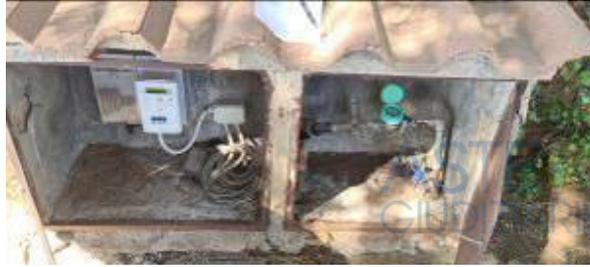
A tale dispositivo sono collegati conduttori, che tramite tubazione interrata e sottotraccia, alimentano il quadro elettrico di distribuzione dell'appartamento, posizionato nel disimpegno. Il quadro elettrico è realizzato con un centralino in resina dotato di sportello e fissato su contenitore incassato nella muratura.
