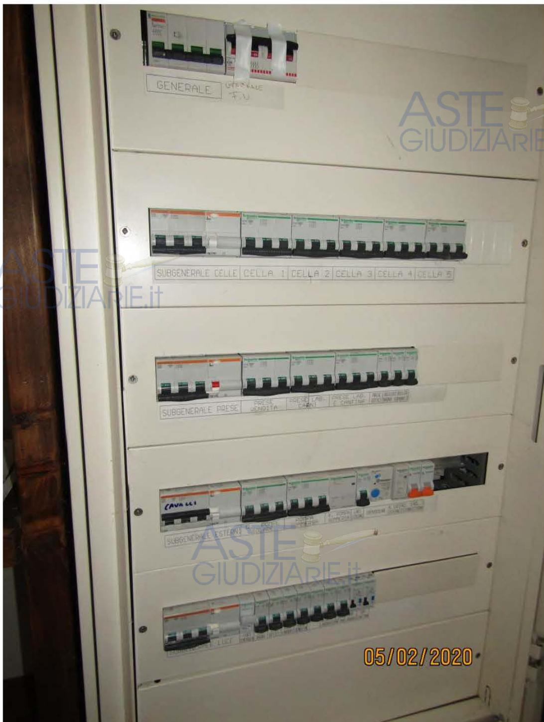
Il quadro elettrico generale, dotato di sportello di chiusura, delle targhette identificatrici delle utenze e dei moduli disponibili all'interno della carpenteria risulta essere sezionabile in quattro principali circuiti, ovvero, circuito celle frigo, circuito FM, circuito utenze esterne, sia FM che luce esterna e circuito luce.
