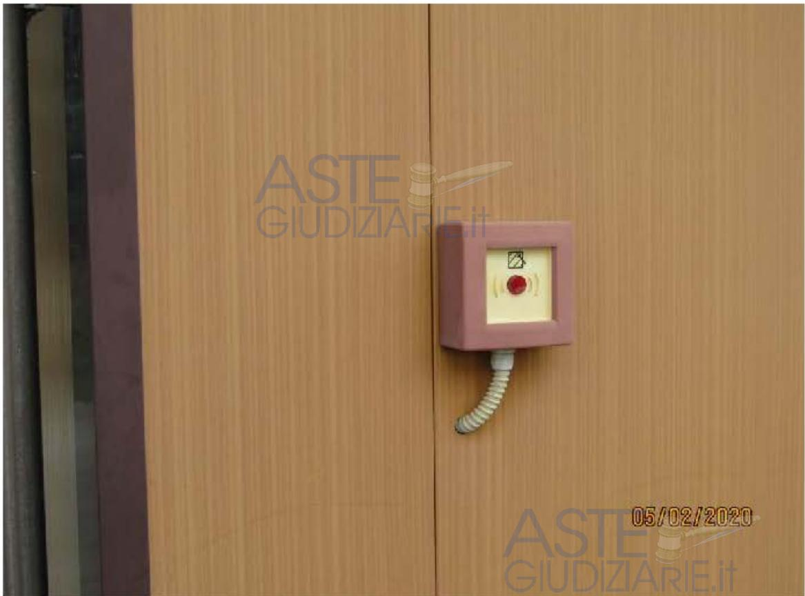
All'impianto elettrico, in caso di emergenza, potrebbe essere tolta la tensione previa rottura del vetro del pulsante di sgancio ubicato, in aderenza, sul prospetto principale del fabbricato.
